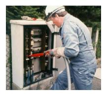
**Bild:** Bei Reinigungsarbeiten unter Spannung ist die persönliche Schutzausrüstung zu benutzen.
